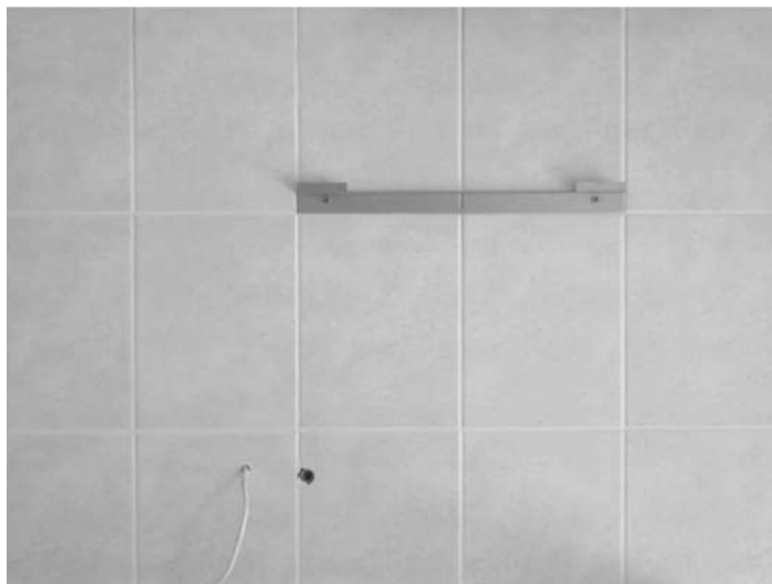
Пример подготовки к подключению прибора к электросети, слива конденсата и монтажа консоли.
