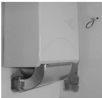
Вид с соседнего помещения
